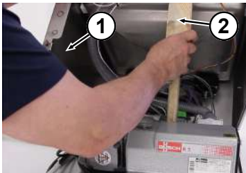
Abb. 19: Gehäuse anheben
